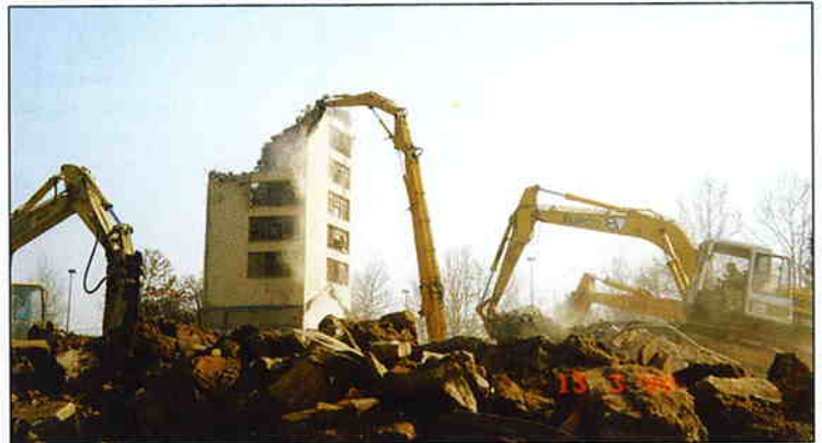
rušenje objekta - detalj
