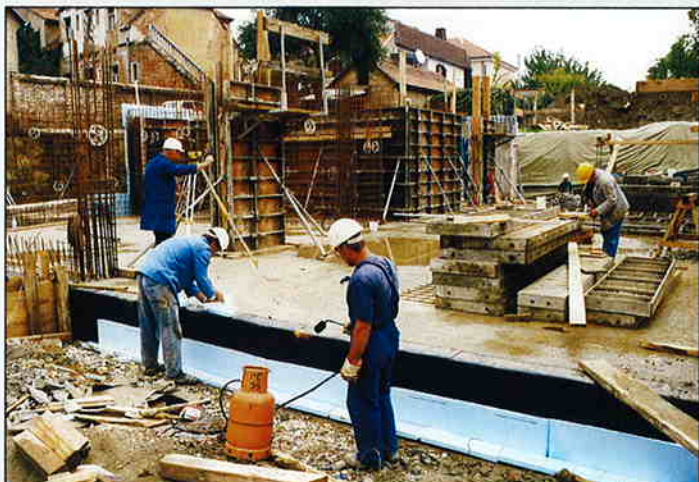
Početak gradnje stambeno poslovne zgrade na Črnomercu
