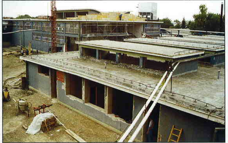
Objekti u početku adaptacije
