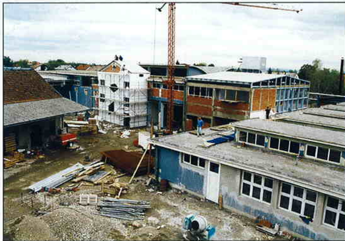
Objekti u završetku grubih građevinskih radova
