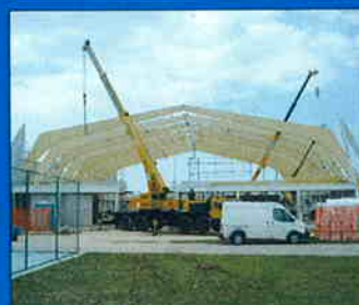
IZGRADNJA ŠKOLSKE SPORTSKE DVORANE UMAG
