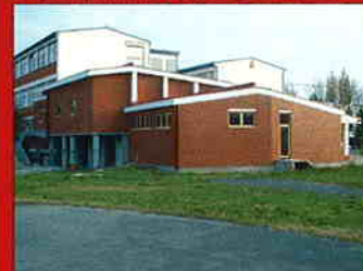
Zatvaranje i obzidanje fasade dvorane za predavanja Geoteh. fakulteta u Varaždinu Investitor Geotech. fakultet Varaždin
