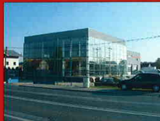
Posl. proidajni centar Molydon u Zagrebu Invest. Molydon, Zagreb, Površ. građevine 1.800 m 2 , izvođenje grube konstrukcije
