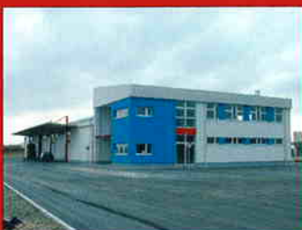
Skladišna hala MGP, Čakovec Investitor MGP, Čakovec Površina 1.200 m 2
