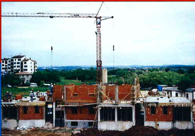
STAMBENA GRADEVINA MOELA, UMAG
