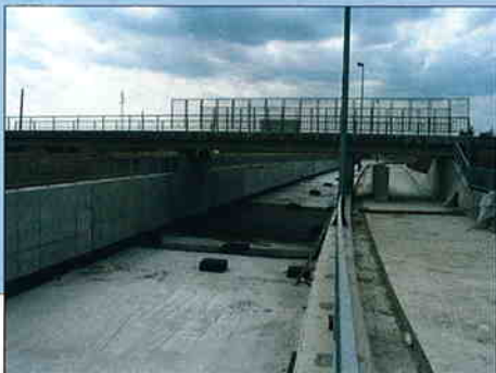
JUŽNA ZAOBILAZNICA GRADA ČAKOVCA Podvožnjak ispod željezničke pruge Investitor: G.I.U. obilaznica Čakovec Predviđeni završetak radova - srpanj 2005.
