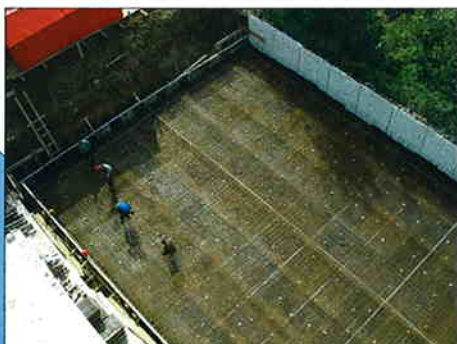
Stambena građevina 'NEHAJSKA' Investitor: ALBATROS d.o.o., Zagreb Površina: 1.615 m 2 Predviđeni završetak radova - veljača 2006.
