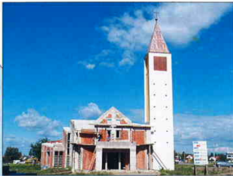
II. FAZA IZGRADNJE CRKVE U SAVSKOJ VESI Investitor: Biskupija Varaždinska, RKT Župa Marije Pomoćnice Strahoninec Predviđeni završetak radova: prosinac 2005.
