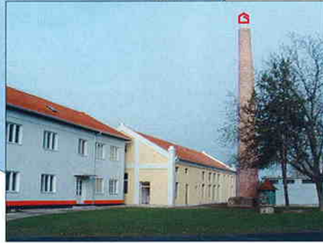
ADAPTACIJA GRAĐEVINE U MURSKOM SREDIŠĆU - proizvodnja pića Investitor: TEAM d.d. Čakovec Površina: 700 m 2 Predviđeni završetak radova: veljača 2006.
