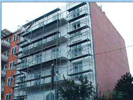
STAMBENA GRAĐEVINA, Zagreb Nehajska Investitor: ZAGREB-ALBATROS d.o.o., Zagreb Površina: 1.615 m 2 Predviđeni završetak radova: veljača 2006.
