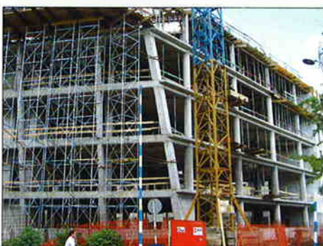
I. FAZA IZGRADNJE BIBLIOTEKE FILOZOFSKOG FAKULTETA SVEUČILIŠTA U ZAGREBU Investitor: Filozofski fakultet Sveučilišta u Zagrebu Površina: 8.050 m 2 Predvideni završetak radova: srpanj 2006.
