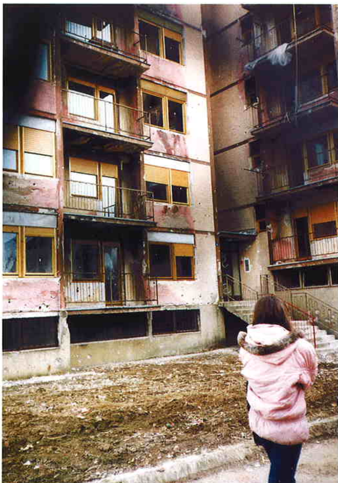
OBNOVA STAMBENE ZGRADE U HEBRANGOVOJ ULICI - PAKRAC
