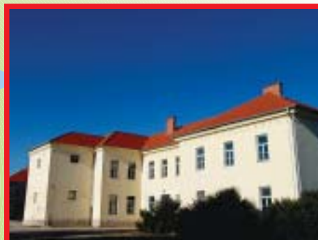
ADAPTACIJA OBJEKATA 4 I 5 U KRUGU BIVŠE VOJARNE ZA POTREBE ŠKOLSKOG PROSTORA EKONOMSKE I TRGOVAČKE ŠKOLE ČAKOVEC Investitor: Međimurska županija Površina: 2.800 m 2 krova završeno
