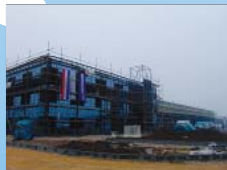
IZGRADNJA MAN PRODAJNO-SERVISNOG CENTRA D.O.O. I MAN IMPORTER, HRVATSKI LESKOVAC Investitor: MAN Prodajno servisni centar d.o.o. Površina: 6.000 m 2
