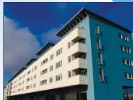
IZGRADNJA STAMBENO POSLOVNE GRAĐEVINE SESVETE B2, SESVETE Investitor: TEHNIKA d.d. Površina: 6.480,00 m 2
