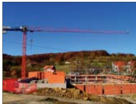
IZGRADNJA DVODIJELNE ŠPORTSKE DVORANE U SKLOPU KUPALIŠNOG KOMPLEKSA TOPLICE SVETI MARTIN Investitor: Toplice Sveti Martin d.d. Površina: 1.700 m 2
