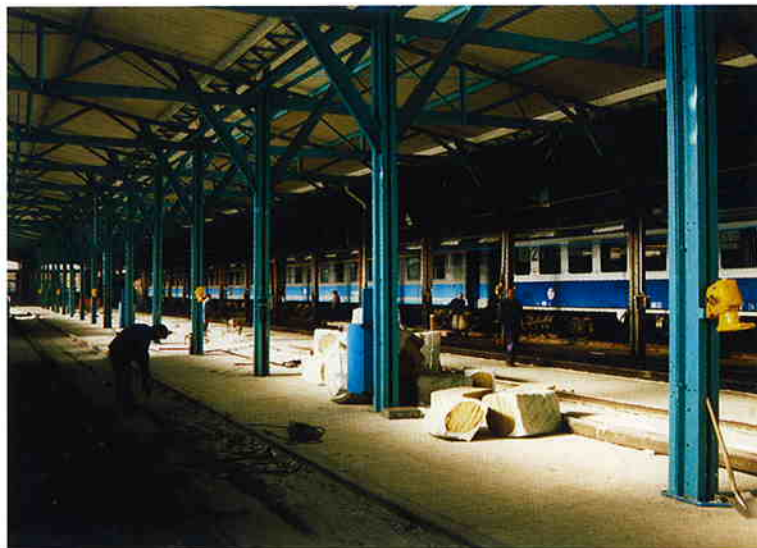
Gradilište Hrvatske željeznice
