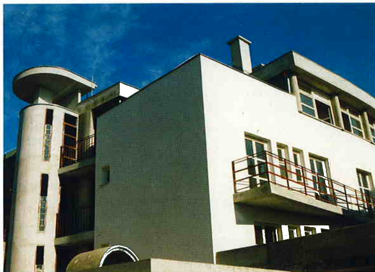
Gradilište Vile Vrhovec
