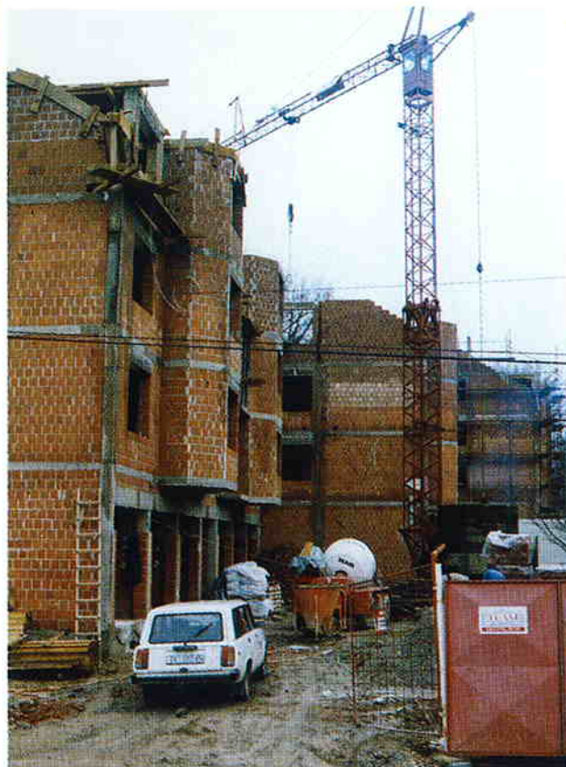
Stambene zgrade Sesvete
