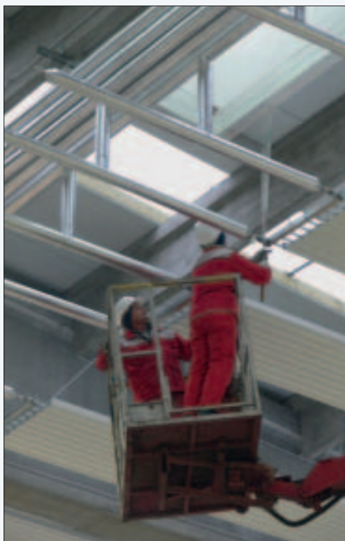
Završni radovi na stropu
