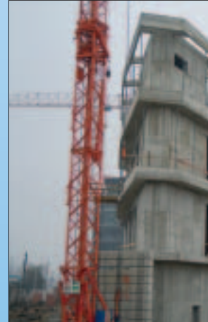
REKONSTRUKCIJA I DOGRADNJA POSLOVNE GRAĐEVINE, ZAGREB Investitor: VIPnet d.o.o., Zagreb Površina: 3.600,00 m 2
