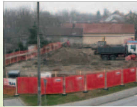
REKONSTRUKCIJA GRAĐEVINE ZA DRUŠTVENE DJELATNOSTI, STRAHONINEC Investitor: Općina Strahoninec Površina: 1.183,00 m 2
