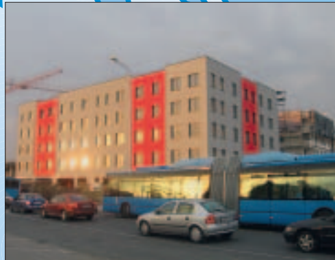
IZGRADNJA STAMBENO-POSLOVNIH GRAĐEVINA, G-3, G-4 I G-5, NINSKA ULICA, SESVETE Investitor: RB Supermetali d.o.o., Sesvete Površina: 7.200,00 m 2
