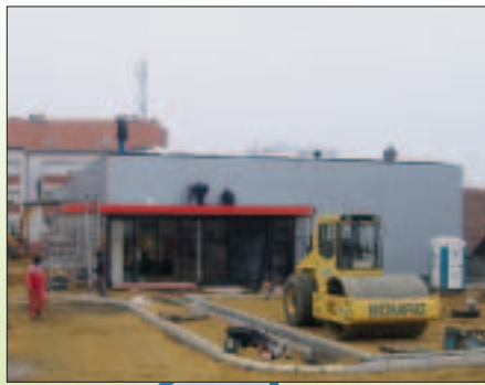
IZGRADNJA PRODAVAONICE KONZUM, KOTORIBA Investitor: Pet Prom d.o.o., Zagreb Površina: 500,00 m 2
