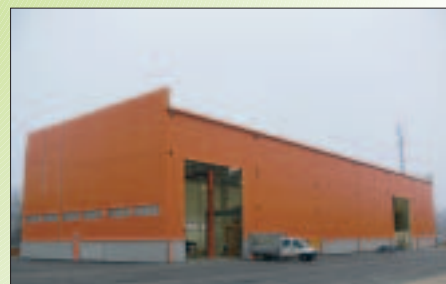
IZGRADNJA PREFABRICIRANE AB KONSTRUKCIJE I LAKIRNICE METALNIH ZAVARENIH KONSTRUKCIJA, ŠENKOVEC Investitor: EKO Međimurje d.d., Šenkovec Površina: 1.800,00 m 2
