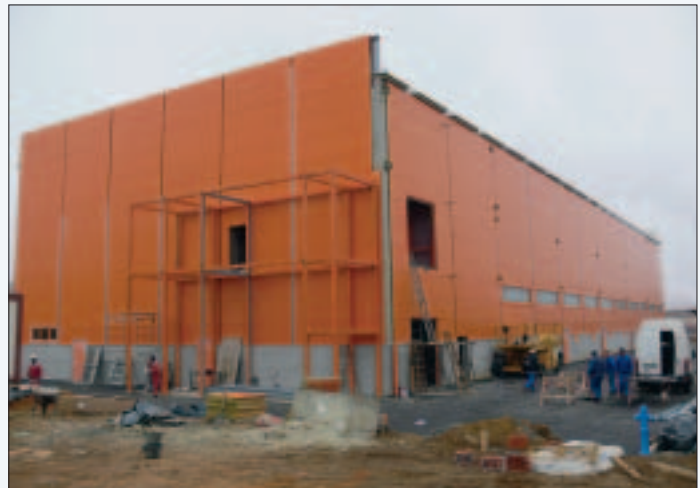
Završni vanjski radovi na novoj lakirnici
