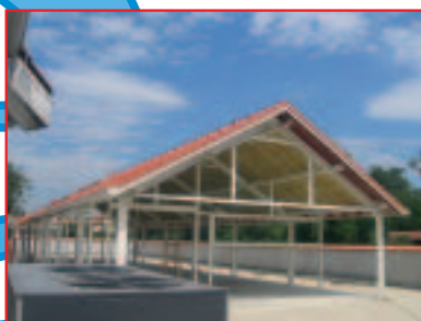
IZGRADNJA POMOĆNE PROIZVODNE GRAĐEVINE, PRELOG Investitor: Vupak d.o.o., Prelog Površina: 285,00 m 2 Završeno
