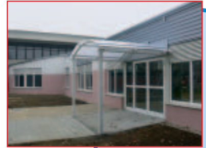
IZGRADNJA SPOJNOG HODNIKA TEHNIČKE ŠKOLE ČAKOVEC Investitor: Međimurska županija Površina: 140,00 m 2 Završeno
