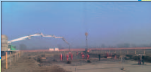
IZGRADNJA SPORTSKO REKREACIJSKOG PARKA TRATE, NEDELIŠĆE Investitor: Nekretnine Nedelišće d.o.o., Nedelišće Površina: 1.200,00 m 2
