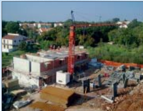
IZGRADNJA STAMBENIH GRAĐEVINA, NASELJE GULIĆI, POREČ Investitor: S. P. Nekretnine d.o.o. Površina: 2.113,00 m 2
