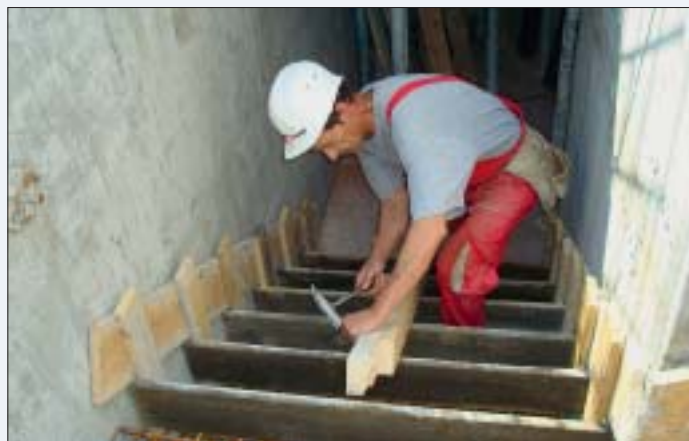
Mladen Turk, zadužen za izradu oplate stubišta
